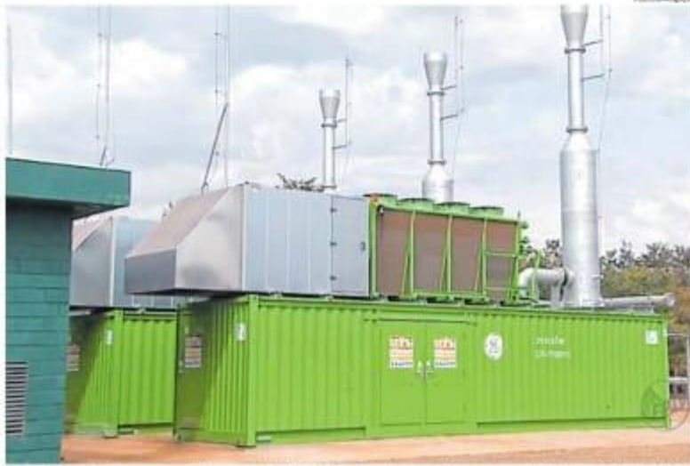
Plantas de biogás similares a essa localizada no estado de São Paulo estão sendo construídas no aterro sanitário do município de Rosário
